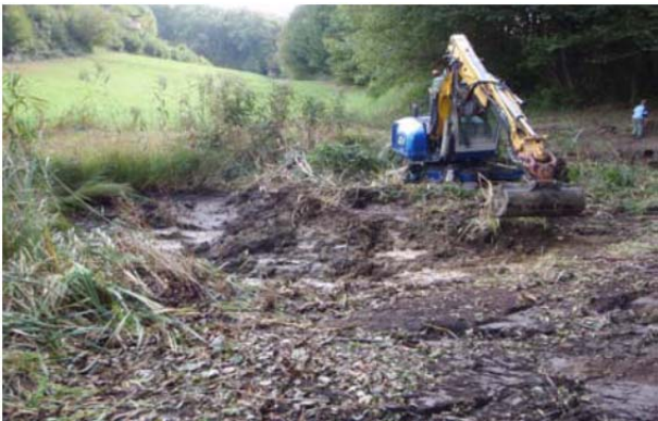
Ausbaggern eines Gewässers in einer Senke am Waldrand, die natürlicherweise vernässend ist.
