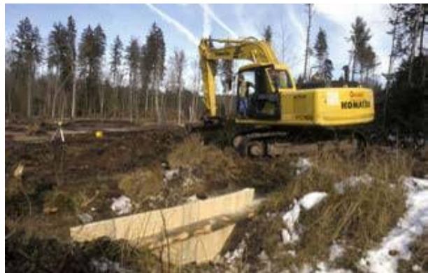
Das Aufstauen von Entwässerungsgräben ermöglicht das Entstehen eines grossen Gewässers mit minimalen Kosten.
